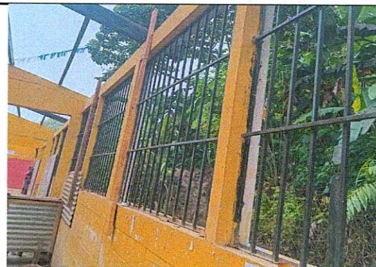
Foto 4: Mantenimiento a estructura de metal de ventanas (lijado, cepillado y pintura)
