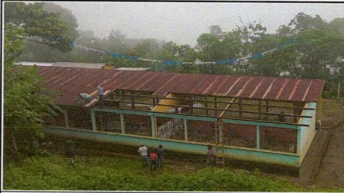
Foto1: Sustitución de entechado de aulas
