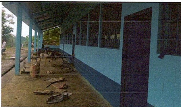
Foto 5: Pintura de muros para exterior e interiores de aulas
