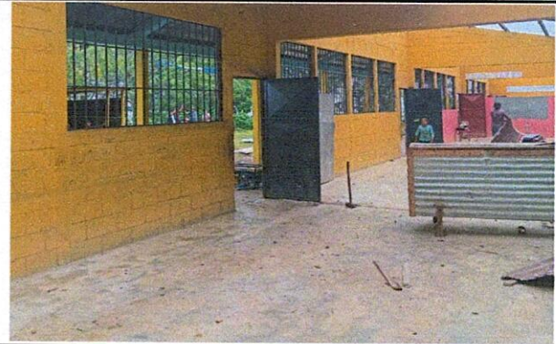
Foto 2: Sustitución de puertas
